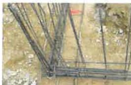
Nœud de chaînage - Continuité mécanique
