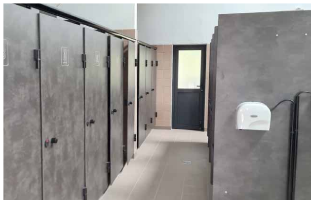
Les sanitaires après travaux
