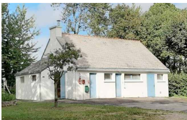
Le Bâtiment sanitaire avant travaux
