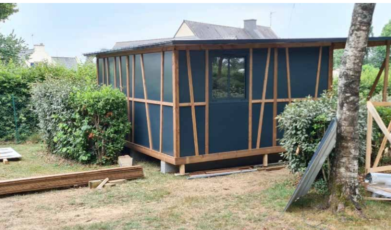
Nouveaux chalets en cours de montage.
